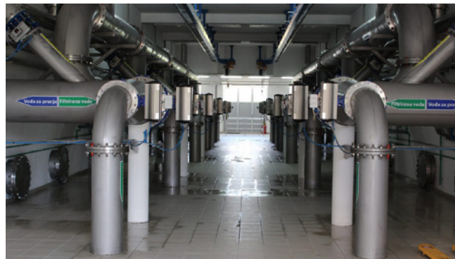
Fabrika vode - Sistem za filtriranje sa senzorima
